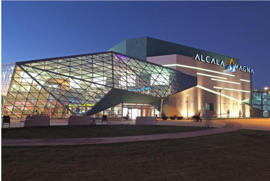
Centro Comercial Alcalá Magna, Alcalá de Henares, Madrid
